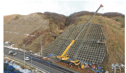
道路斜面の防災対策
