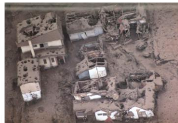
住宅の被害状況
