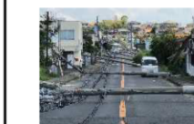
＜電柱倒壊による道路閉塞＞
