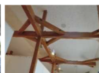
＜道の駅の耐震対策＞
