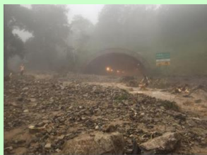
8/31被災時(法面崩壊)
