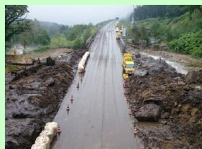
9/1通行止め解除時
