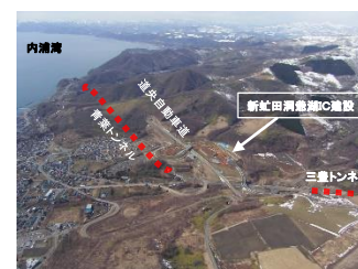
国道230号 新虻田洞爺湖IC建設作業
