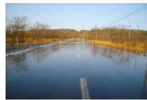
冠水状況(H25.4.8) (厚岸町寒辺牛)
