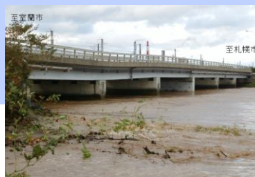
被災状況 ～橋脚が沈下～
