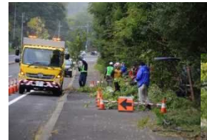
作業車で伐採木を回収
