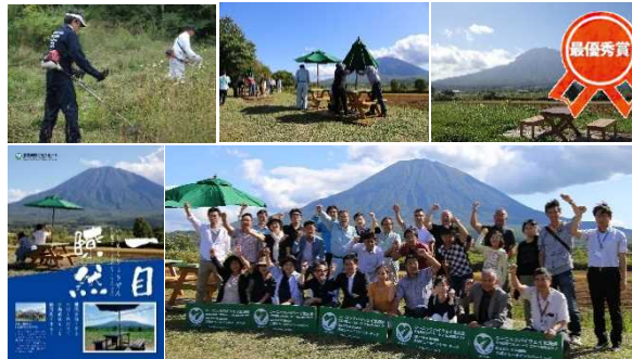
ベスト・シーニックバイウエイズ・プロジェクト2017 ～地域・電線管理者と連携した「電線の見えない化」～ ビューポイントパーキングの景観改善 (電線移設) (支笏洞爺ニセコルート)
