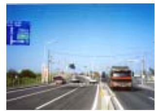
【整備後の状況】
