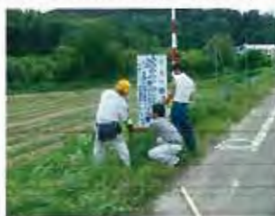
仮設誘導看板設置状況
