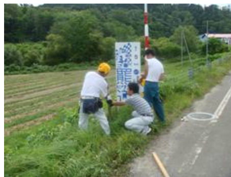
仮設誘導看板設置状況
