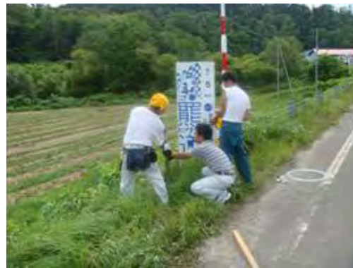
仮設誘導看板設置状況
