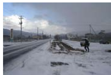
不要看板の撤去（平成16年度）
