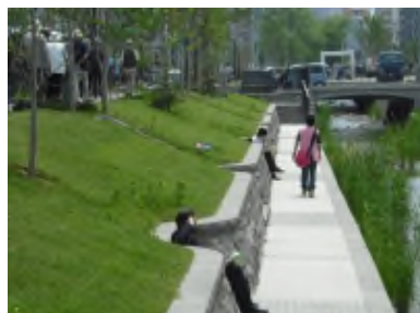
二段護岸による整備
