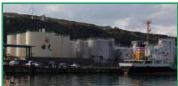
稚内港に立地する石油タンク
