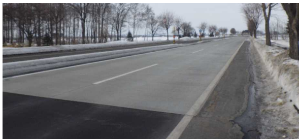
試験施工状況（音更）
