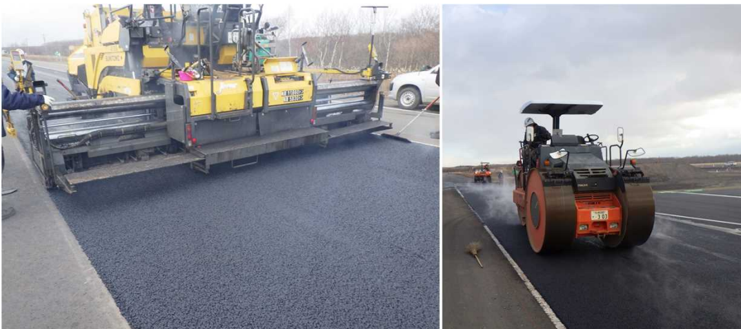
試験施工状況
