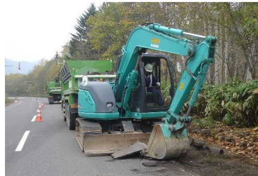
路肩部打ち換え
