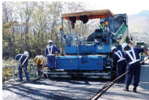
レベリング施工
