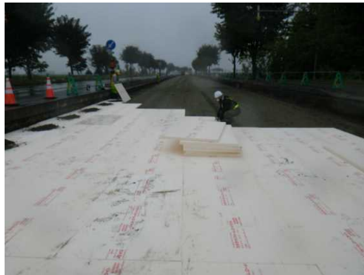
断熱材設置状況
