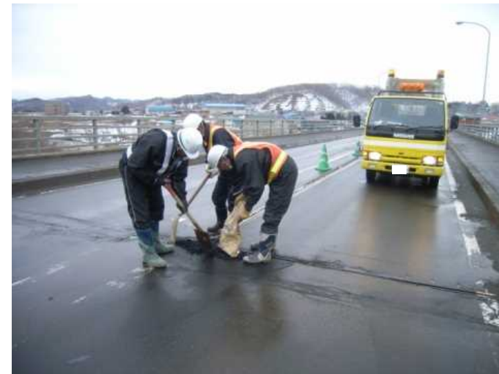
応急対策として、常温合材による穴埋め その後、加熱合材によるパッチングを実施
