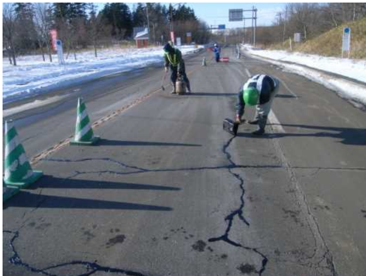
補修材の注入による補修
