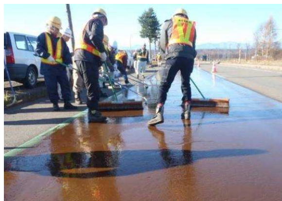
試験施工状況
