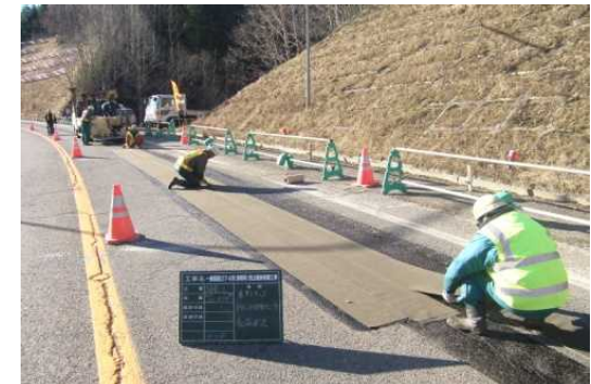
クラックシートによる補修
