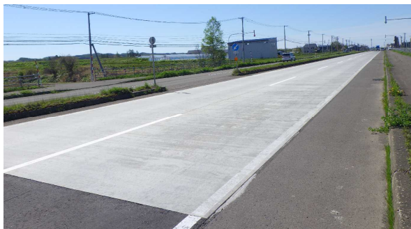
試験施工状況（岩見沢）
