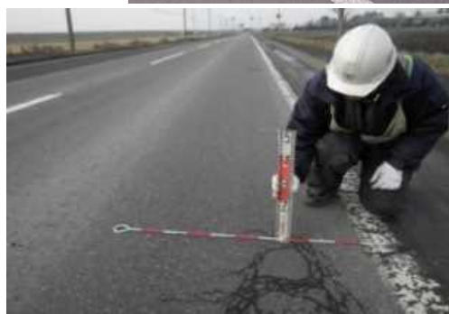
▲現地における舗装点検状況
