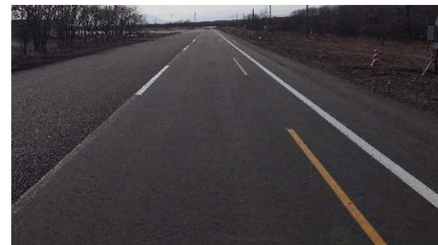
試験施工状況
