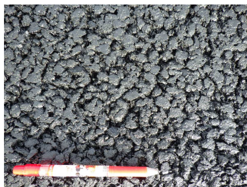
試験施工後の路面状況
