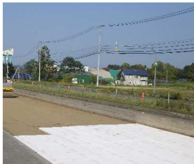
断熱材敷設状況
