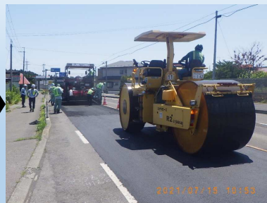
1次転圧 (マカダムローラ)
