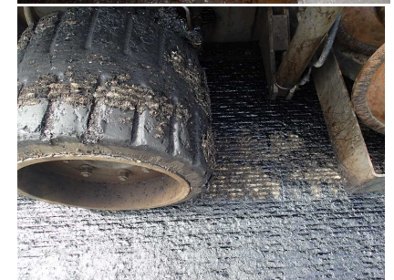
ダンプタイヤ(上)とフィニッシャタイヤ(下)によるはがれ
