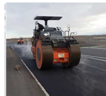
苫小牧寒地試験道路における試験施工の状況
