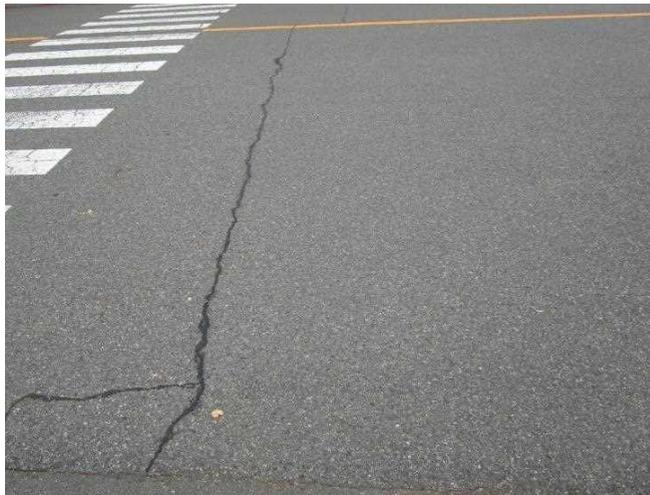
アスファルト舗装のひび割れへの注入
