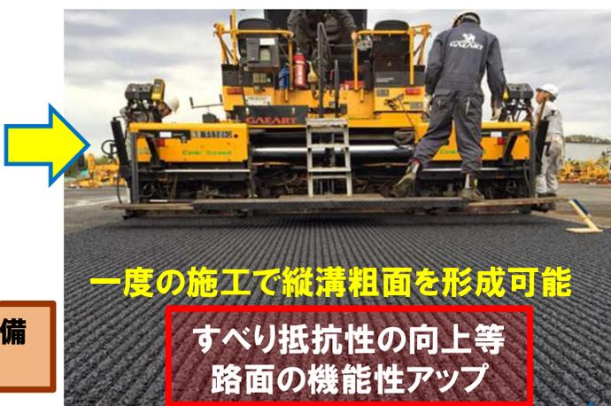
一度の施工で縦溝粗面を形成可能
