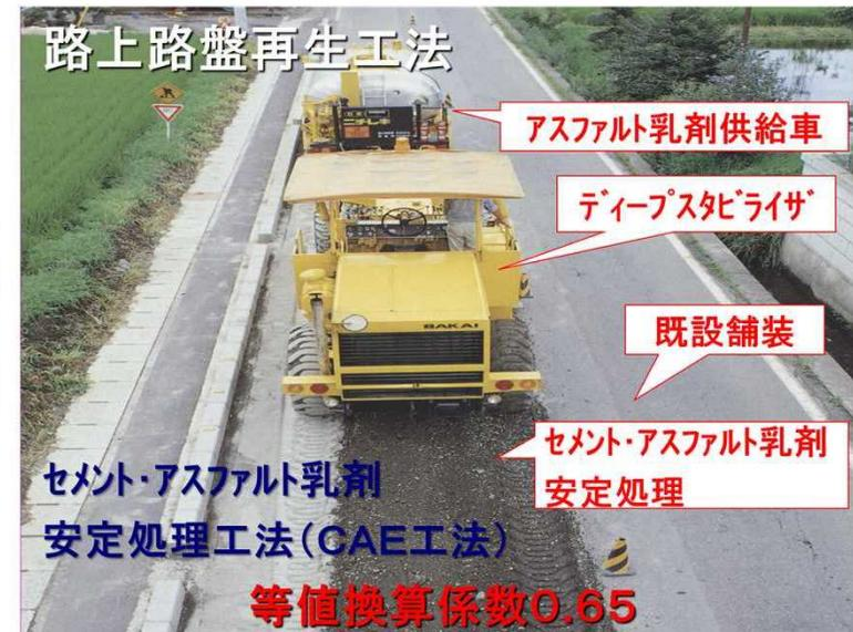
路上路盤再生工法の施工
