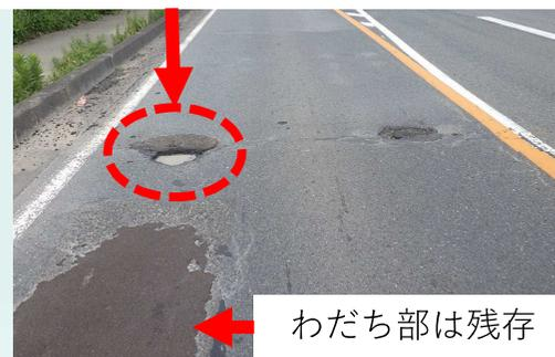
写真-7 破損状況(αミックス)
