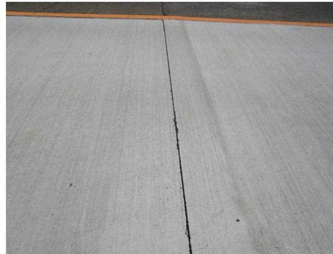
コンクリート舗装の目地部への注入
