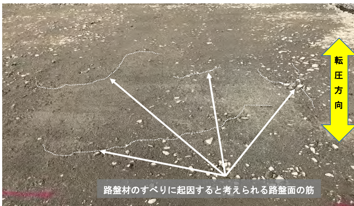
写真-2 路盤状況 (路盤厚 t=15cm)
