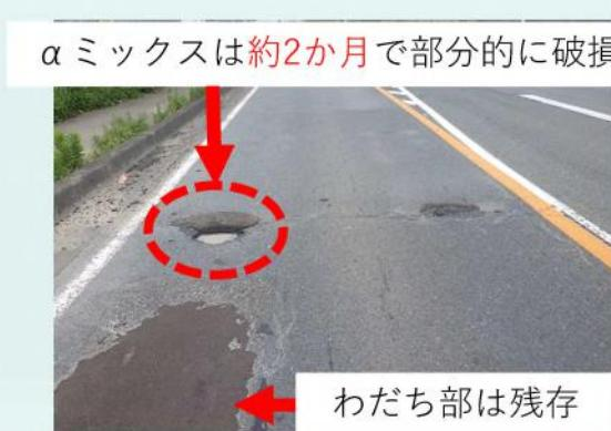
写真-7 破損状況( $\alpha$ ミックス)
