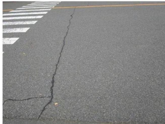
アスファルト舗装のひび割れへの注入
