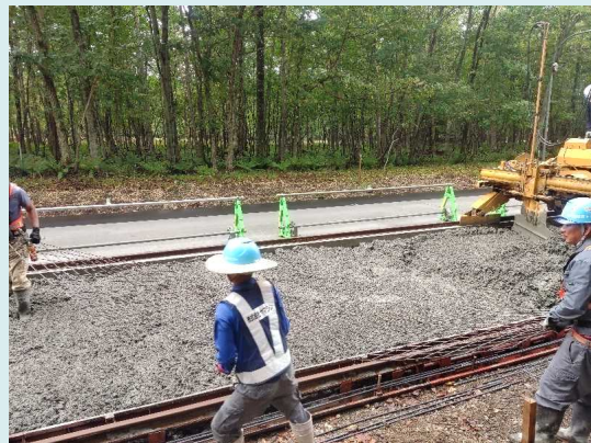
鉄網・縁部補強鉄筋の設置
