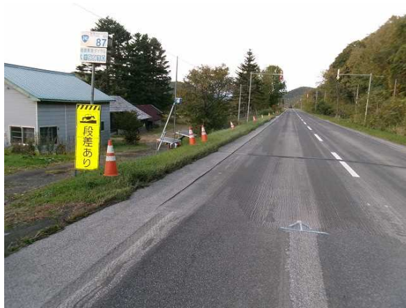
試験施工箇所起点
