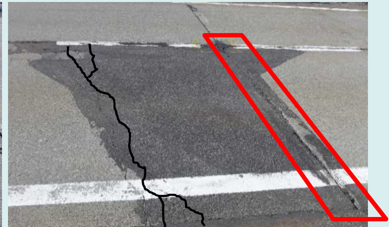
目地部の段差・コンクリート舗装版のひび割れおよび沈下
