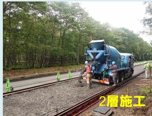
生コンの2層施工
