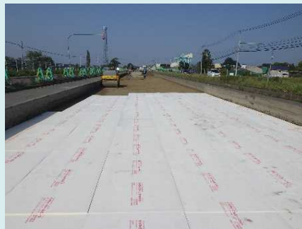
断熱材敷設状況
