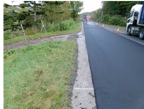
転圧完了後路面
