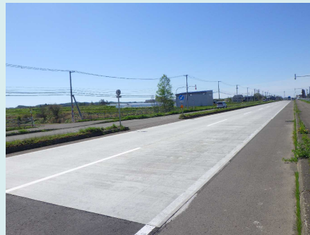
コンクリート舗装供用状況(試験施工箇所)
