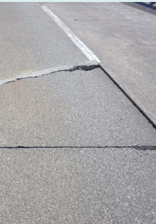
目地部の段差・コンクリート舗装版のひび割れおよび沈下
