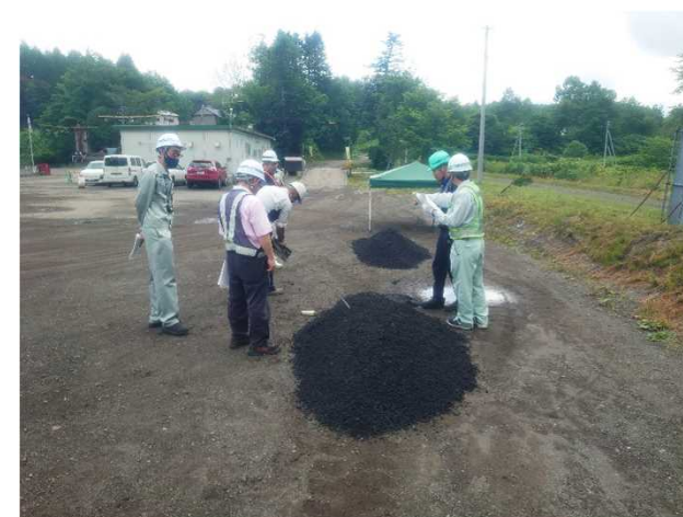
羊蹄アスコンでの試験練り状況 (2023.07.25)
