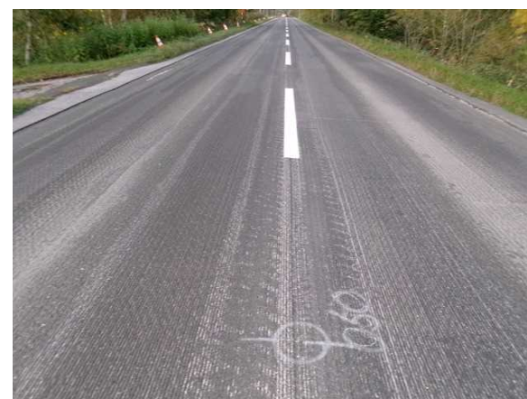
施工終点(起点から50m)
