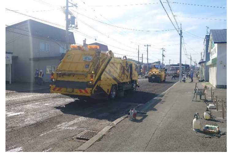
写真4 余剰プレコート骨材除去
