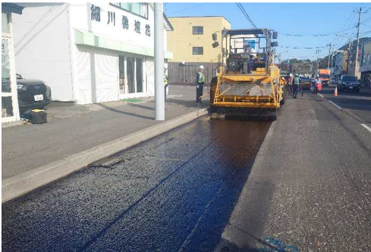
写真2 プレコート骨材散布
