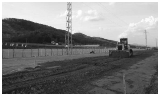
写真7.2 吸着層の施工状況
