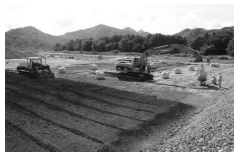
写真7.1 人工吸着材を用いた吸着層の施工
