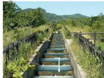
③階段式魚道
