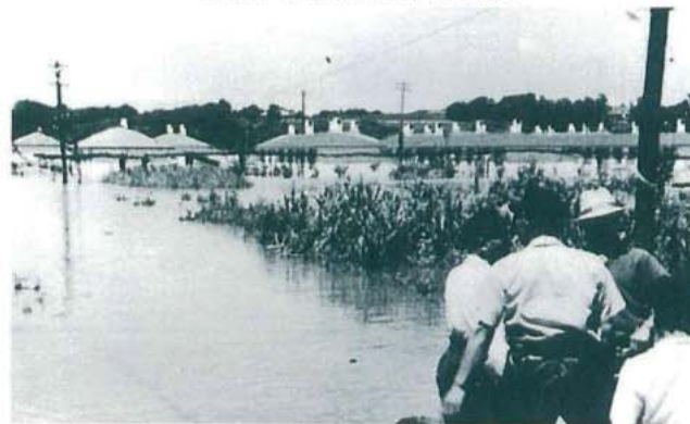
昭和37年8月洪水 (西丹羽地区の家屋浸水と田畑の冠水)
