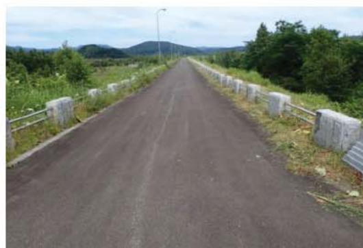
視点場（ダム天端）
