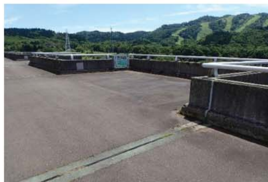
視点場（ダム天端）
