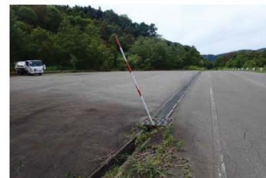
駐車場の整備状況
