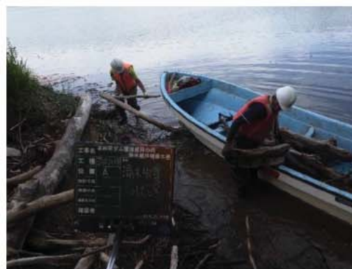
流木の引き上げ状況
