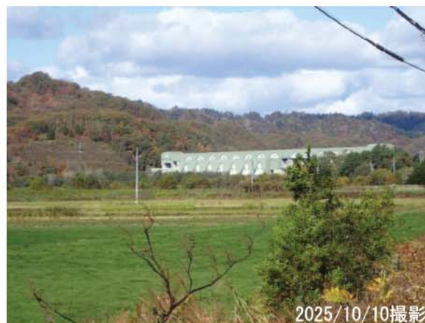
国道237号からの眺望（下流側）
