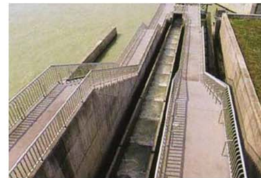
階段式魚道 (二風谷式魚道ゲート)
