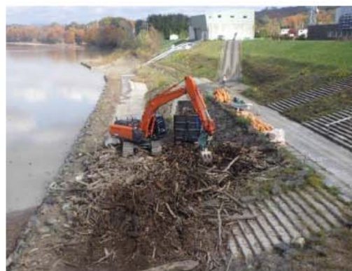
流木の引き上げ状況
