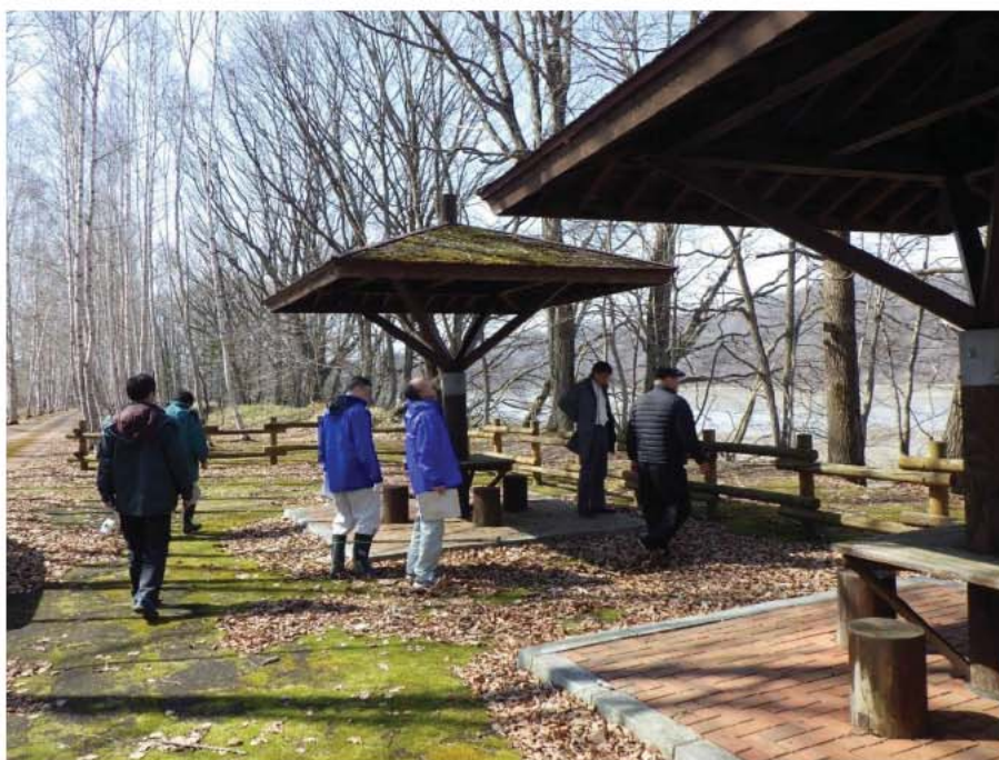
四阿・ベンチ、進入防止柵の確認状況（R6.4.11撮影）
