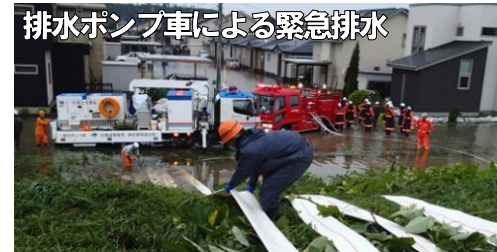
応急対策【被害拡大防止】
