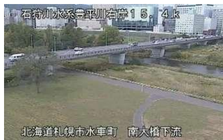
南大橋右岸下流CCTV
