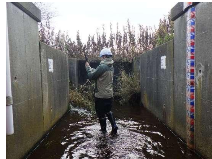
樋門内点検（ひび割れ検知）
