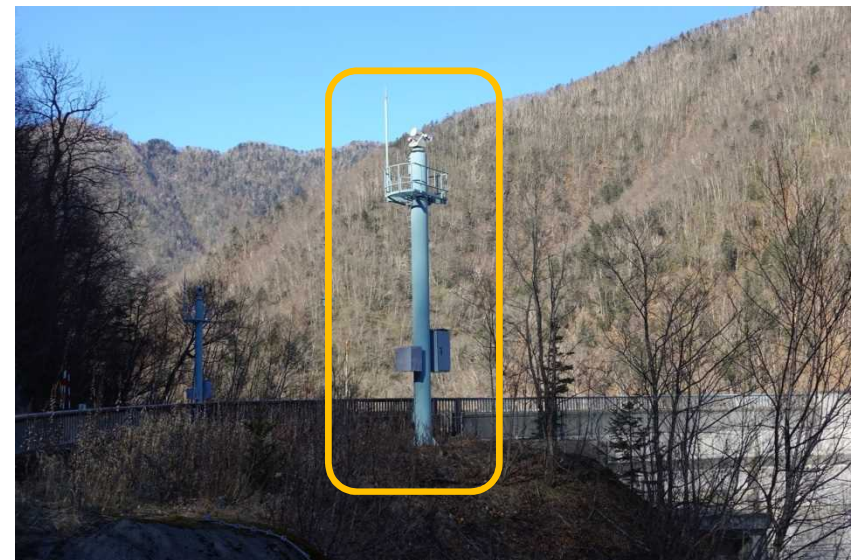
監視カメラ鉄塔の塗装色 が周辺の類似施設と 異なる
