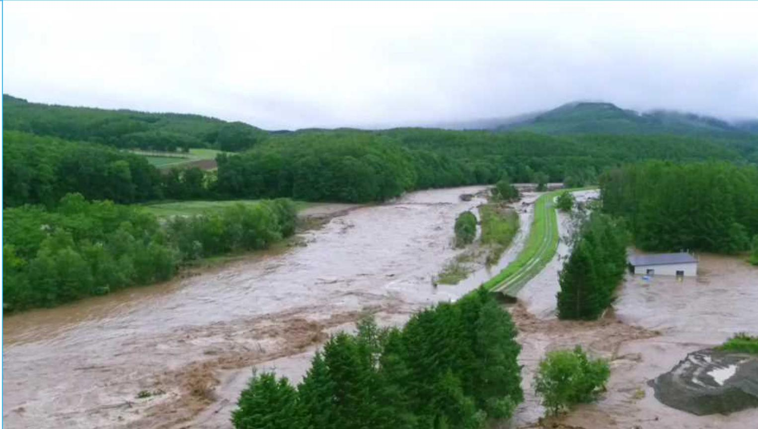
事例：空知川上流において、平成28年8月北海道豪雨災害で発生した堤防破堤の状況
