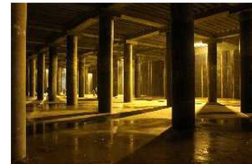
貯留施設の整備
