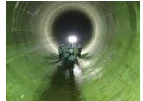
雨水貯留管の整備
