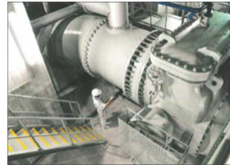
雨水ポンプの整備
