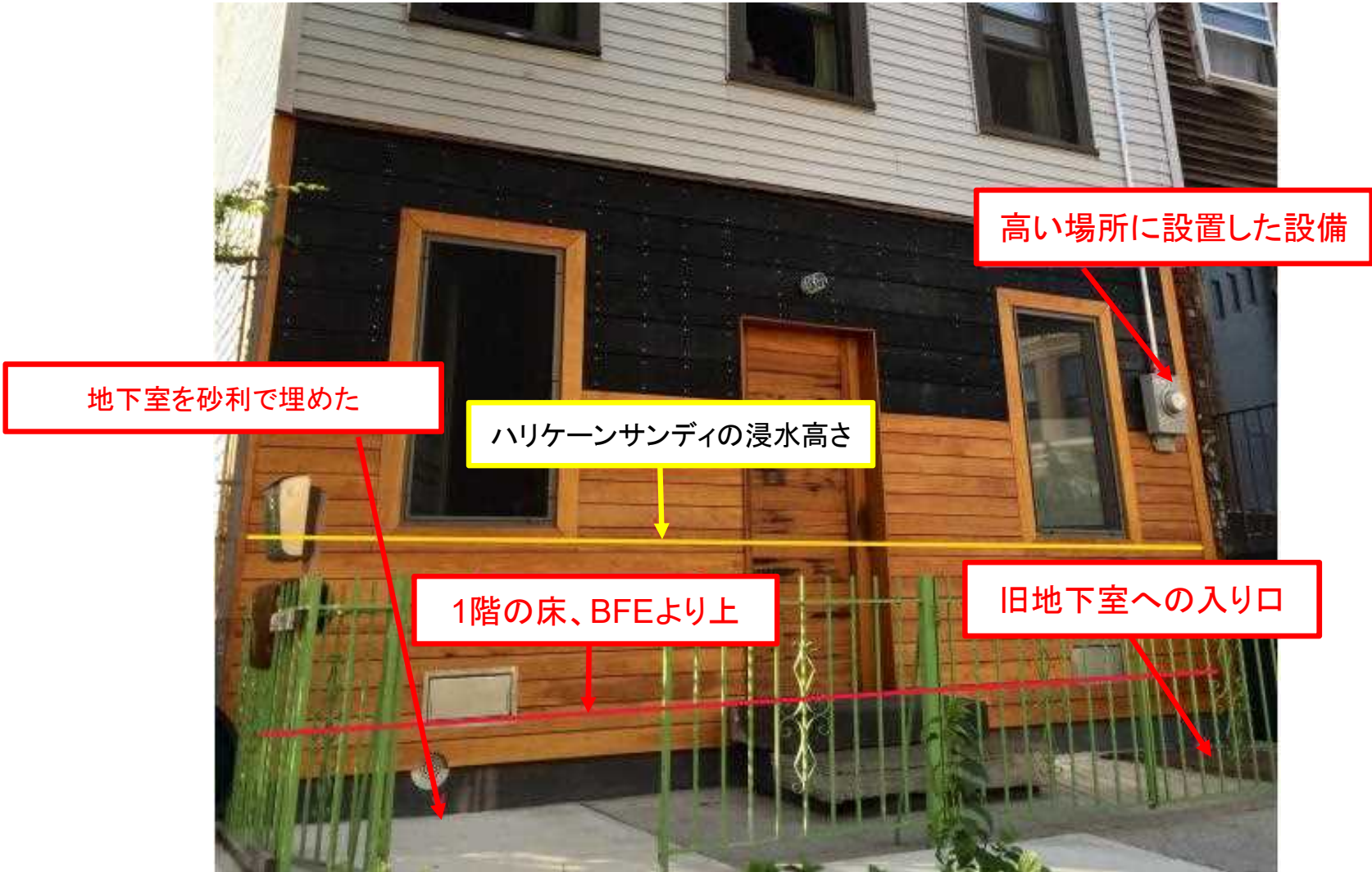
ハリケーンサンディによって浸水被害を受けた住宅の対策事例
