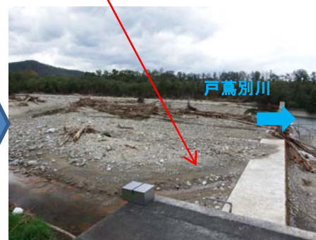
被災後の戸蔦別川第1号砂防堰堤 (H28.9撮影)
