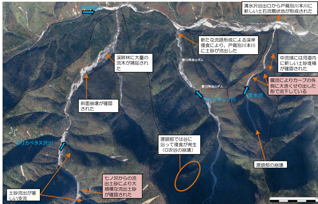
戸蔦別川上流域の荒廃状況
