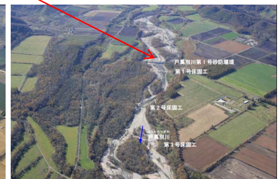
出水後 (平成28年撮影)
