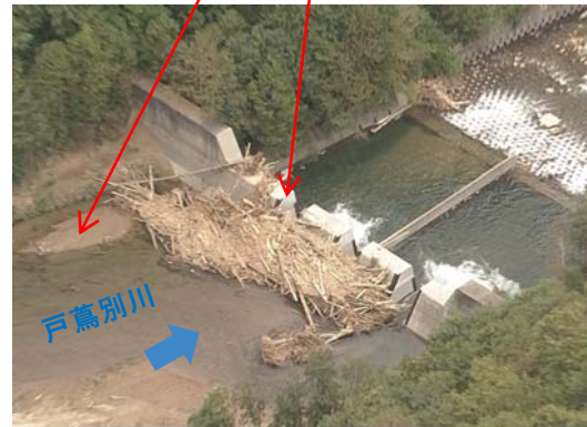
戸蔦別川第7号砂防堰堤
