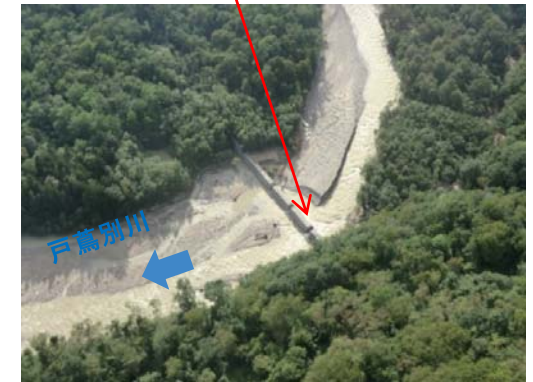
戸蔦別川第5号砂防堰堤
