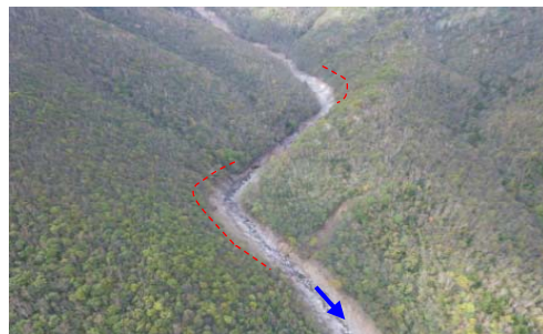
清水沢中流部の偏流状況 (H28.9撮影)
