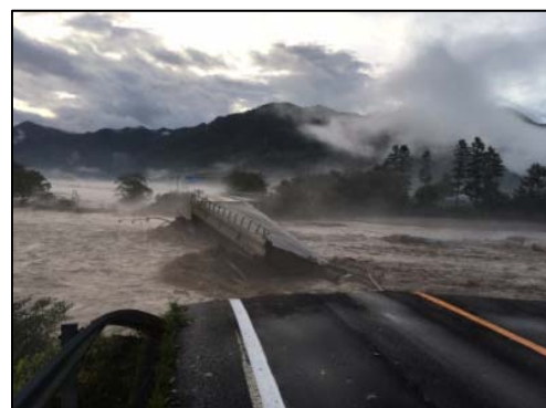
〔千呂露橋(国道274号)〕
