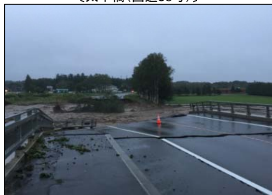
〔小林橋(国道38号)〕
