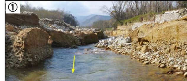
▲ 乱流・河床洗掘により被災した河道
