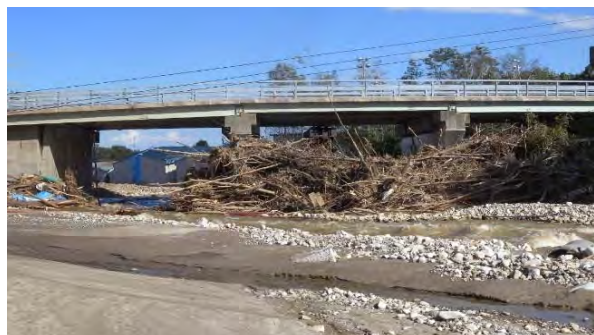
橋脚付近に大量に堆積した流木 (ペケレベツ川清美橋)
