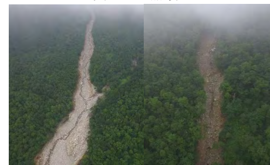
久山川の崩壊地
