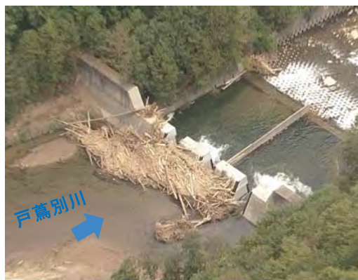
透過型砂防堰堤が流木を捕捉 (戸蔭別川第7号砂防堰堤)
