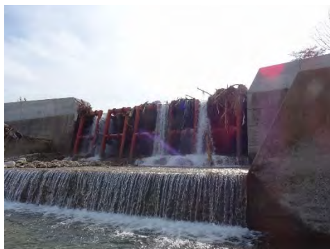
透過型砂防堰堤が流木を捕捉 (ペンケオタソイ川1号堰堤)
