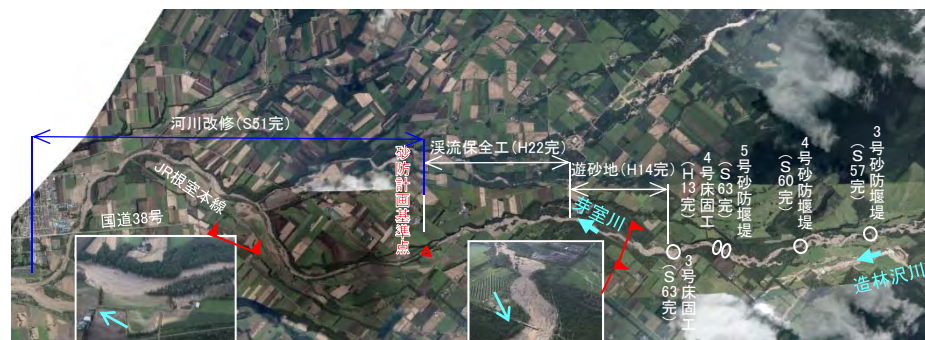
芽室川、造林沢川扇状地の土砂流下状況
