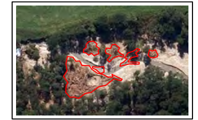
▲ 堆積流木の面積計測
