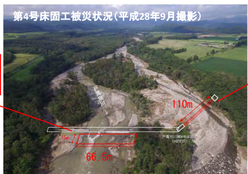
戸蔭別川床固工群の土砂流下状況
