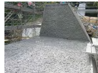
既設砂防堰堤の改良
