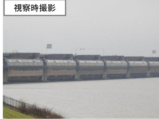
ハーリングフリート水門 (Haringvlietdam)
