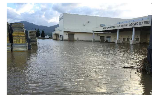
食品加工工場の浸水被害 (H28年8月南富良野町)
