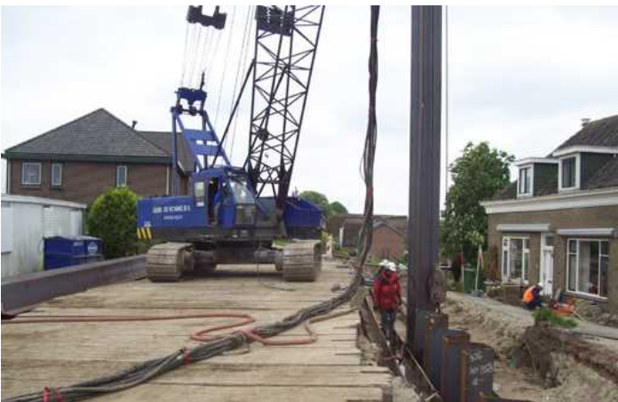
鋼矢板による堤防補強工事状況
