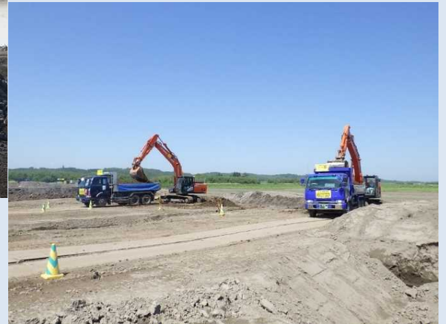
河道掘削等による治水安全度の向上
