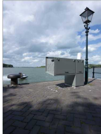
高い位置に設置された電源設備 (オランダの例)
