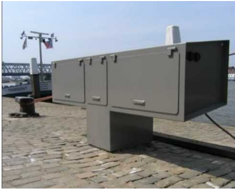
高い位置に設置された電源設備 (オランダの例)
