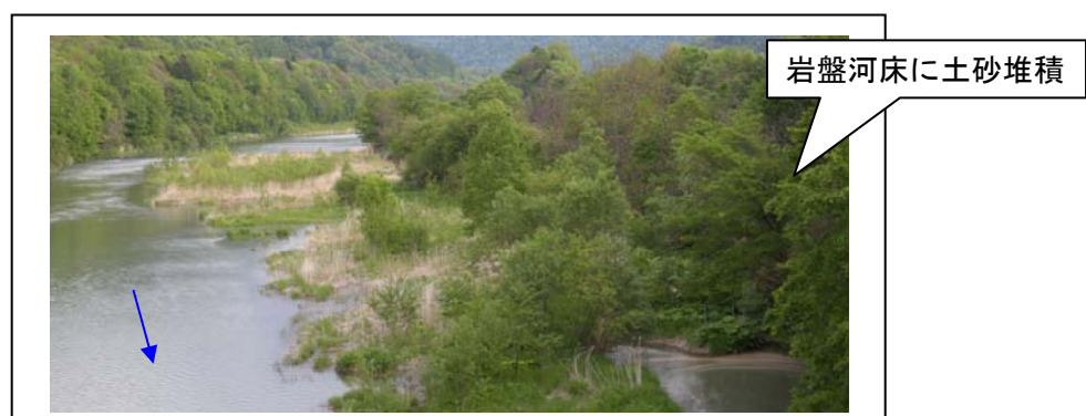
写真 4-1 空知川滝里ダム下流河道の川幅縮小の状況
