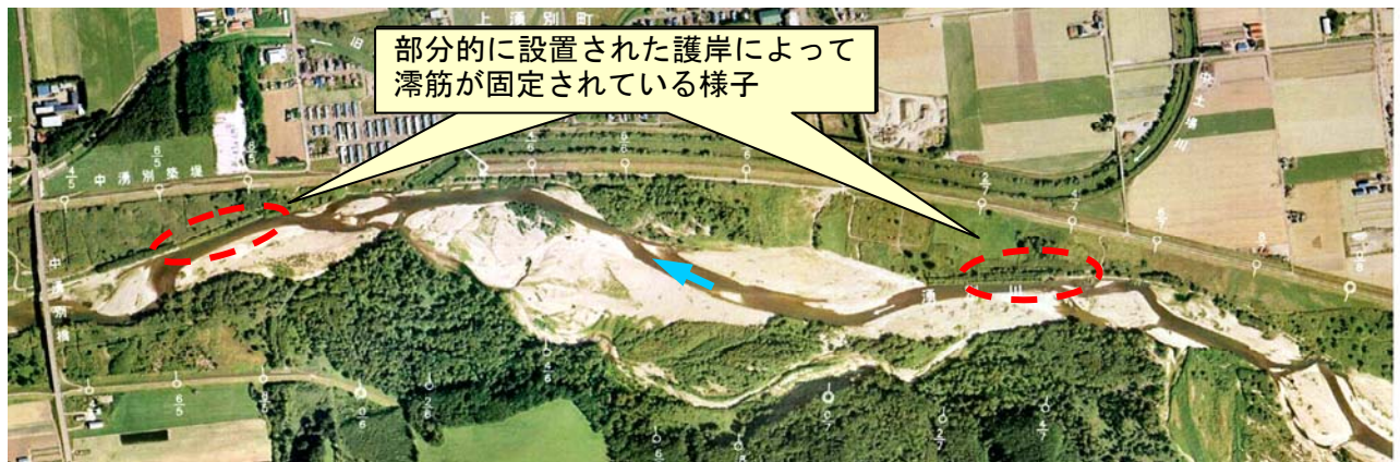
図 4-17 護岸が設置された場合の複列砂州河道の滞筋の固定状況（湧別川 KP6～7 付近）
