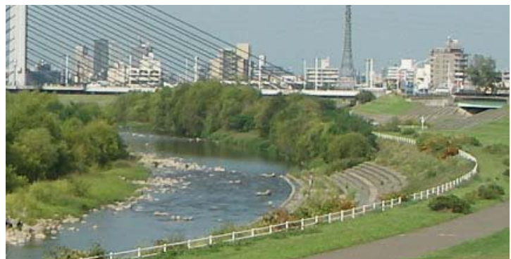
写真 4-5 流速の増大により攪乱力が低下し樹林化が進行したと考えられる河道
