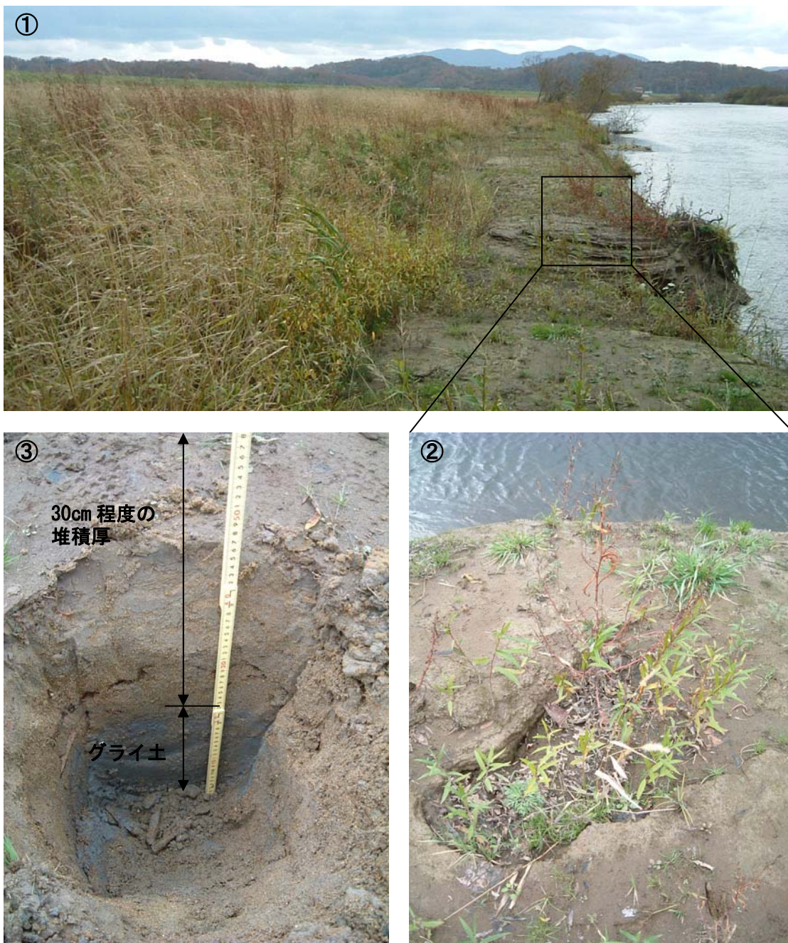
写真 2-6 河岸部の土砂堆積とヤナギの侵入
