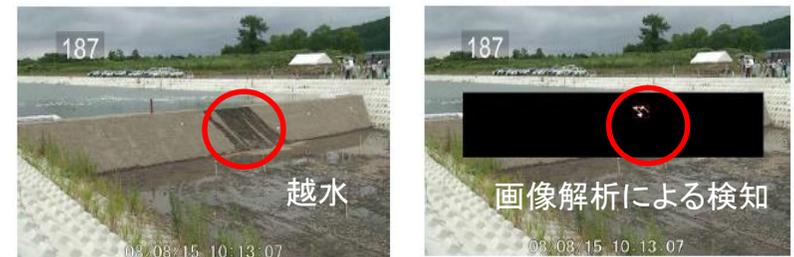
堤防越水時の検知事例(左:撮影画像、右:検知状況)
