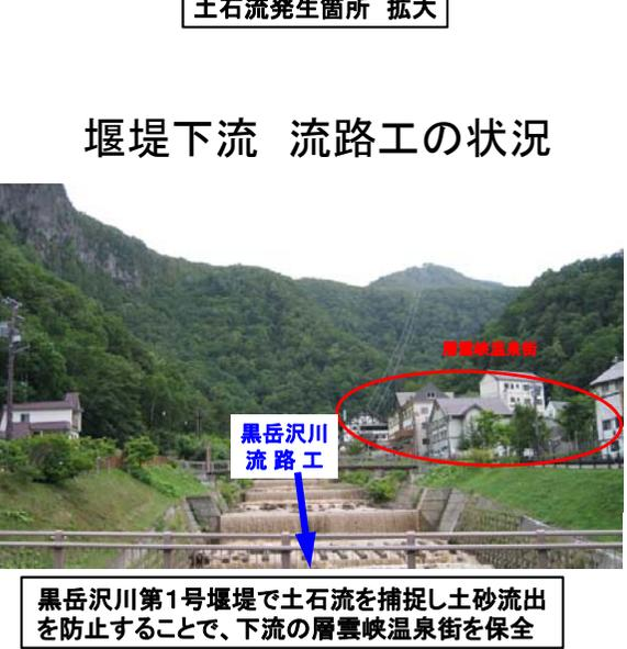
黒岳沢川第1号堰堤で土石流を捕捉し土砂流出を防止することで、下流の層雲峡温泉街を保全
