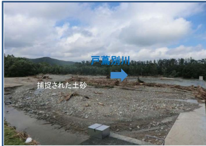
砂防施設による土砂の捕捉効果（平成28年9月2日）
