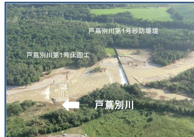
砂防施設による土砂の捕捉効果（平成28年9月1日）
