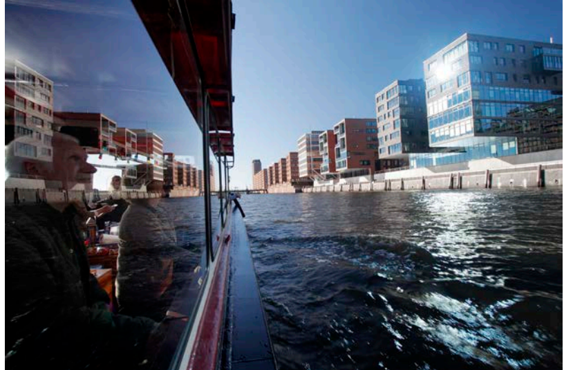
工事現場を見学するクルーズ
