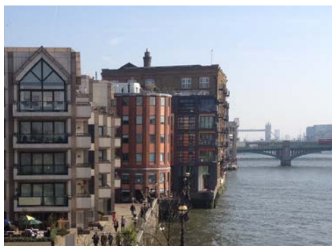
テムズパス(一部は建物1階部分を通過)
