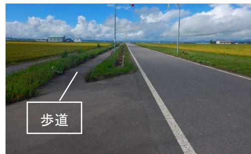
写真：1号支線道路（整備後） （全幅 6.0m、有効 4.0m） （令和7年8月撮影）
