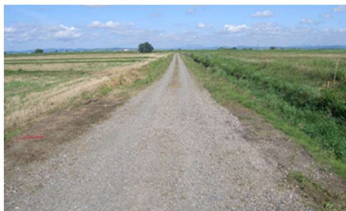
写真：1号支線道路（整備前） （全幅 5.5m、有効 3.5m） （札幌開発建設部）
