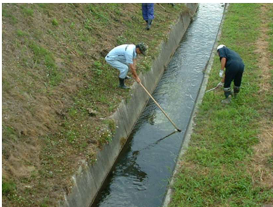
写真：新千代拓殖2号排水路の水路清掃 (妹背牛町提供)
