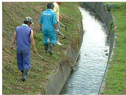
写真：新千代拓殖2号排水路の点検作業 (妹背牛町提供)
