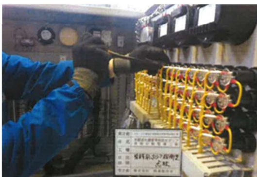
写真：本郷排水機（常時用ポンプ機側 操作盤の点検）（大空町提供）
