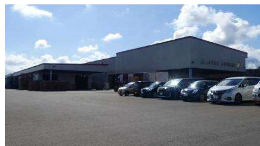
写真：ＪＡびほろ人参選別施設 (令和７年７月撮影)
