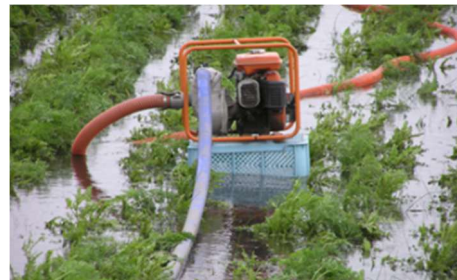
写真：仮設ポンプによる湛水排除 (網走開発建設部提供)
