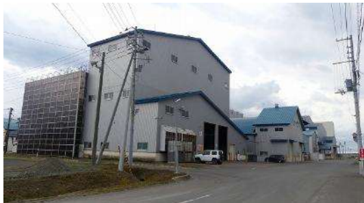
写真：ＪＡめまんべつ麦乾燥調製施設 (令和７年９月撮影)
