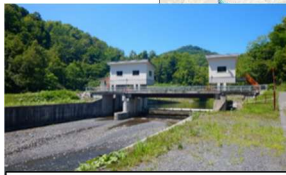
総徳富頭首工（新設）
