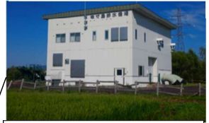
志寸島排水機（新設）
