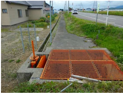
写真：用水路暗渠化（下徳富用水路） （令和7年9月撮影）
