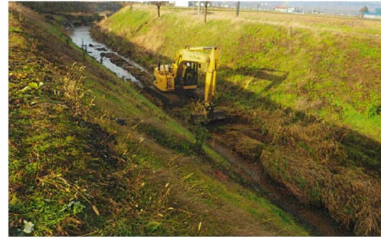
写真：弥生川排水路の土砂除去 (新十津川町提供)
