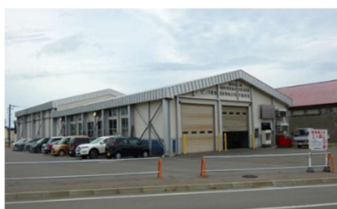
写真：JAピンネ農産物集出荷施設 (令和7年9月撮影)
