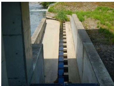
写真：魚道（札豊頭首工） （令和７年７月撮影）
