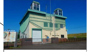
浦臼排水機（新設）
