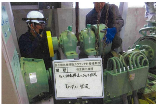
写真：排水機のポンプ設備点検 (新十津川町提供)
