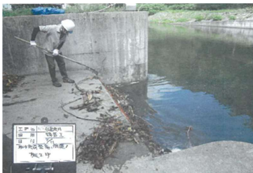
写真：総富地頭首工の除塵作業 （新十津川土地改良区提供）
