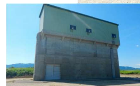
浦臼取水口揚水機（改修）
