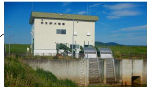
弥生排水機（新設）
