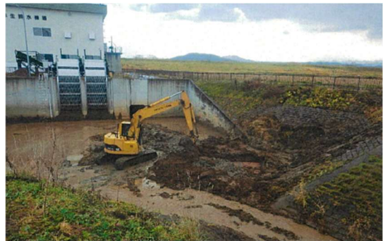
写真：排水機の土砂除去 (新十津川町提供)
