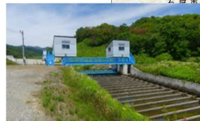
札豊頭首工（新設）
