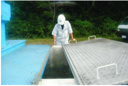
写真：用水路の点検 (雨竜土地改良区提供)
