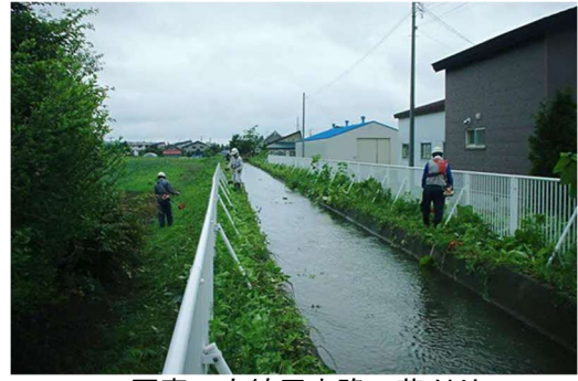
写真：支線用水路の草刈り (浦臼土地改良区提供)
