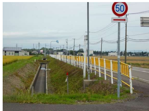
写真：フェンス（下徳富用水路） （令和7年9月撮影）
