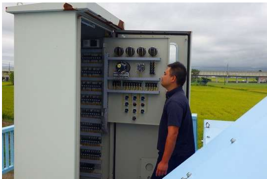
写真：一本木頭首工設備等点検 （渡島平野土地改良区提供）
