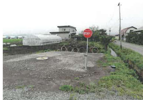
写真：防火用水施設 （渡島平野土地改良区提供）
