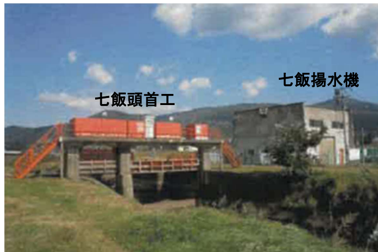
写真：旧七飯頭首工（撤去前）（函館開発建設部）
