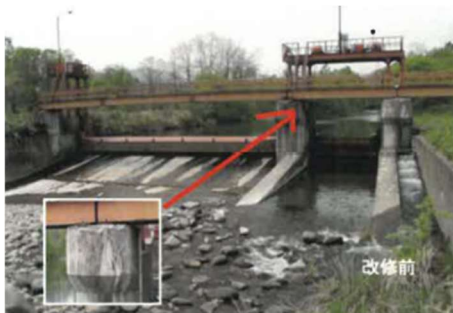
写真：大野川頭首工（整備前） （函館開発建設部）
