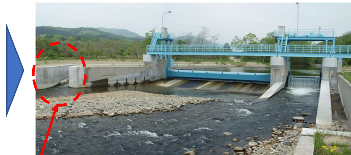
写真：大野川頭首工（整備後） （函館開発建設部）
