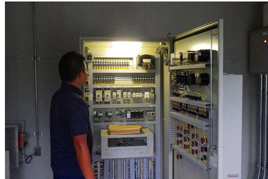
写真：一本木頭首工の設備等点検 （渡島平野土地改良区提供）
