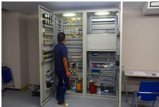
写真：大野川頭首工設備等点検 （渡島平野土地改良区提供）
