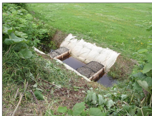
暗渠排水施工時の濁水処理施設 (令和6年6月撮影)
