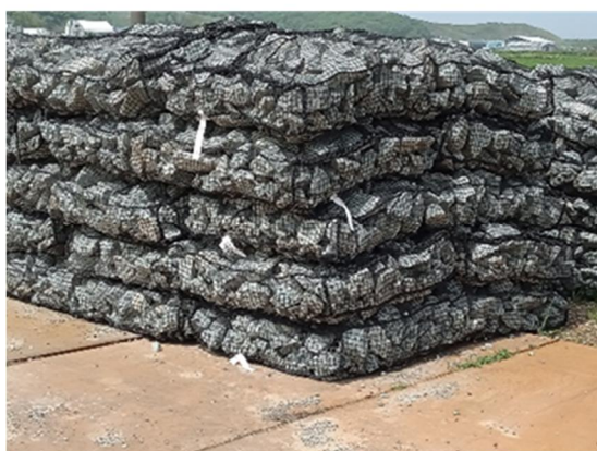
連結ブロックを再利用した中詰材 (令和7年6月撮影)
