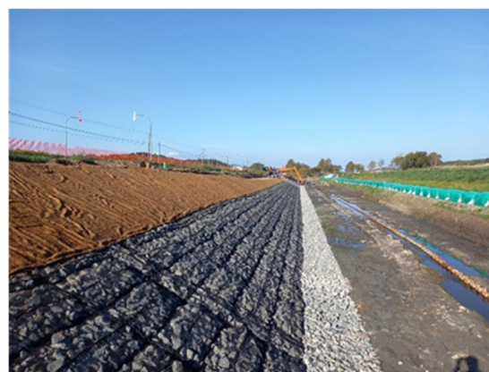
再利用中詰め材を使用した護岸 (令和7年6月撮影)
