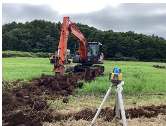
バックホウによる暗渠排水の施工 (令和6年6月撮影)
