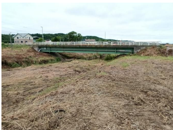
整備前の排水路 (令和6年8月撮影)
