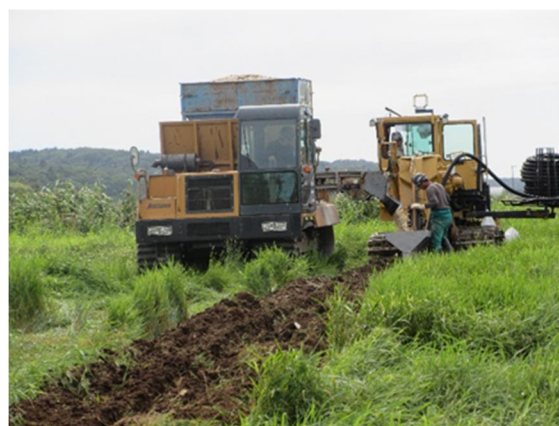
高速自動埋設機による暗渠排水の施工 (令和7年6月撮影)
