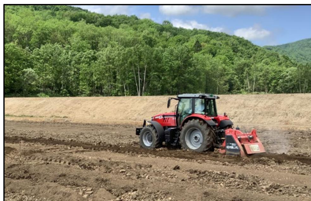
ストーンクラッシャーによる除礫工の施工 (令和2年8月撮影)
