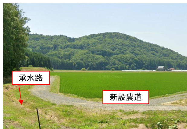
既設承水路の保全 (令和7年7月撮影)
