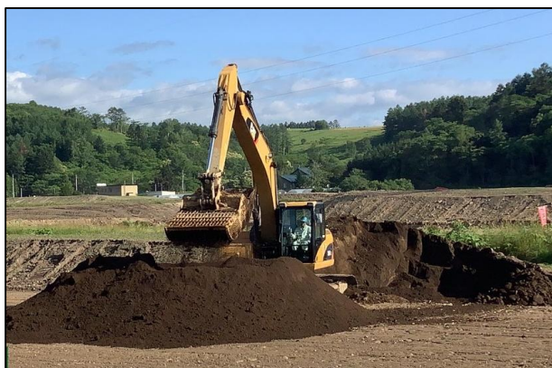
ストーンローダによる除礫工の施工 (他地区参考)
