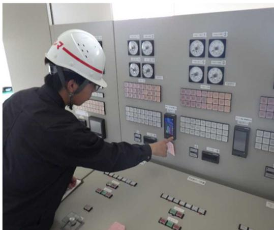
写真：北揚水機 中央操作盤点検 (ながぬま土地改良区提供)
