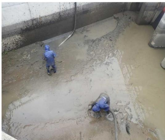
写真：北揚水機の給水槽土砂除去
