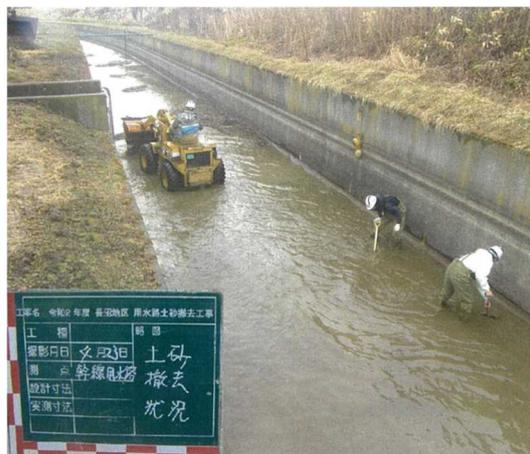
写真：長沼幹線用水路土砂除去
