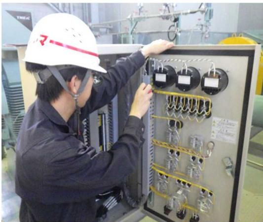
写真：北揚水機 高台幹線ポンプ機側盤点検 (ながぬま土地改良区提供)
