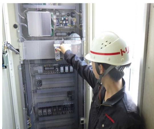
写真：北揚水機 高台幹線ポンプインバーター盤点検 (ながぬま土地改良区提供)
