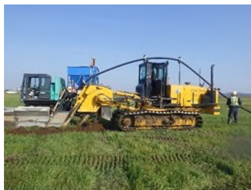
高速自動埋設機による暗渠排水工の施工 (平成 29 年度撮影)
