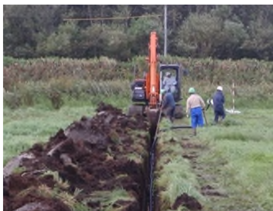
バックホウによる暗渠排水工の施工 (平成 28 年度撮影)
