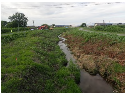
整備前の排水路 (平成 28 年度撮影)
