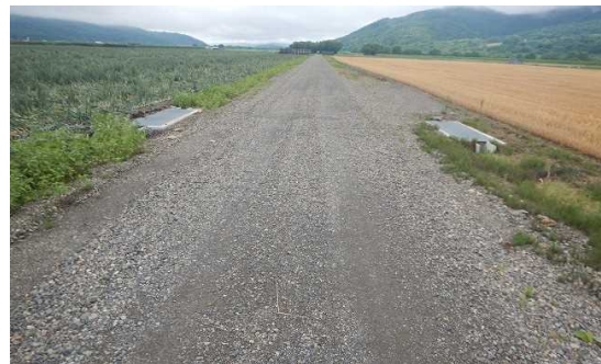
写真：第2号幹線排水路 （地下埋設形式のコンクリート管渠工） （令和6年7月撮影）
