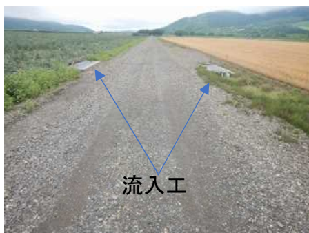
写真：町道西2線（第2号幹線排水路） （令和6年7月撮影）
