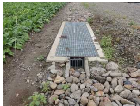
写真：第2号幹線排水路の流入工 （令和6年7月撮影）
