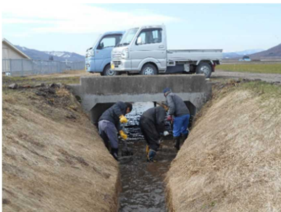
写真：第2号送水路（既設利用） の土砂上げ（湧別町提供）
