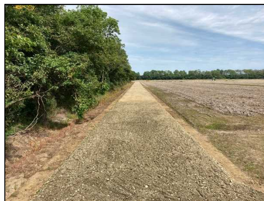
整備後(隣接する防風林を存置) (R2年8月撮影)
