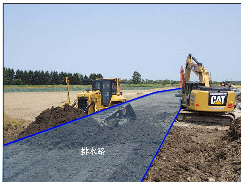
排水路埋戻作業の様子 (R1年7月撮影)
